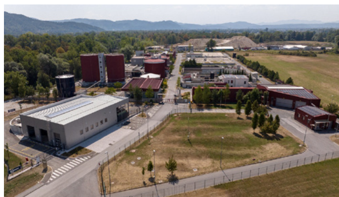
Novi objekt CČN Domžale - Kamnik za nadgradnjo sušenja blata Foto: Mitja Legat, avgust 2026
